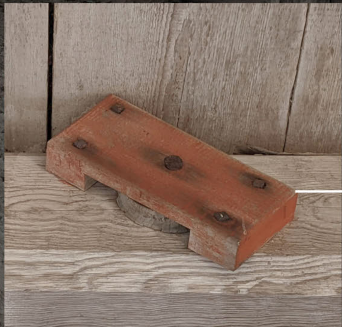
poulie fixée à la poutre
