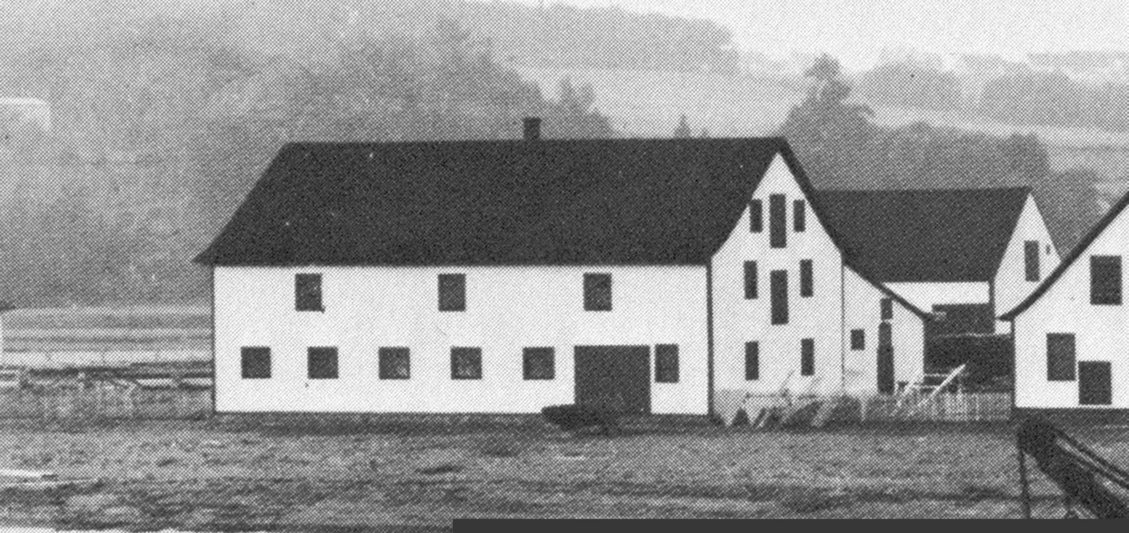
AJOUT D'UNE CHEMINÉE CENTRALE, VERS 1906 PHOTO: ISAAC ERB. ARCHIVES PROVINCIALES DU NOUVEAU-BRUNSWICK
