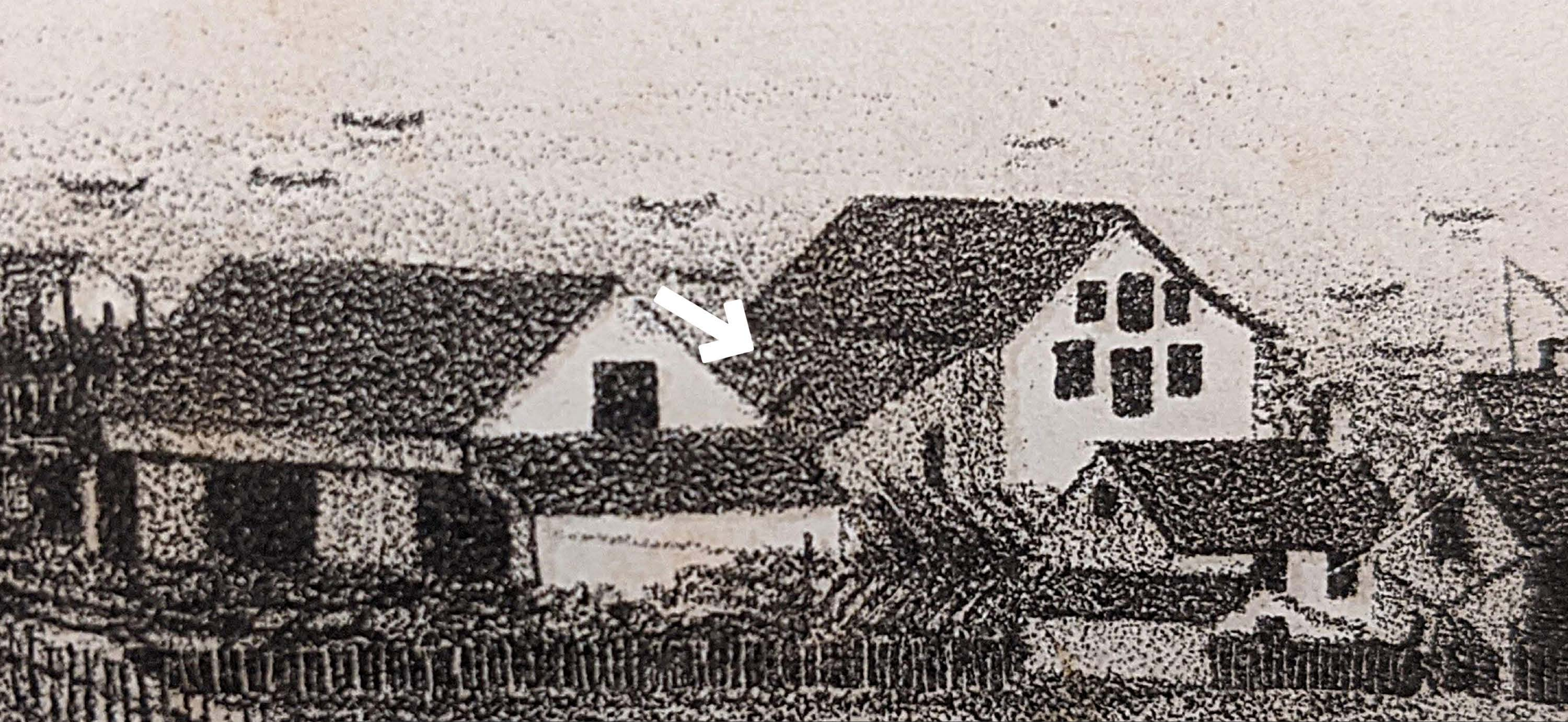
CETTE SECONDE GRAVURE MONTRE L'ANNEXE JUSTE APRÈS SA CONSTRUCTION. L'ANNEXE VA PERMETTRE DE PROTÉGER LES ÉLÉMENTS MAINTENANT SITUÉS À L'INTÉRIEUR. THOMAS PYE, 1866, CANADIAN SCENERY GASPÉ.
