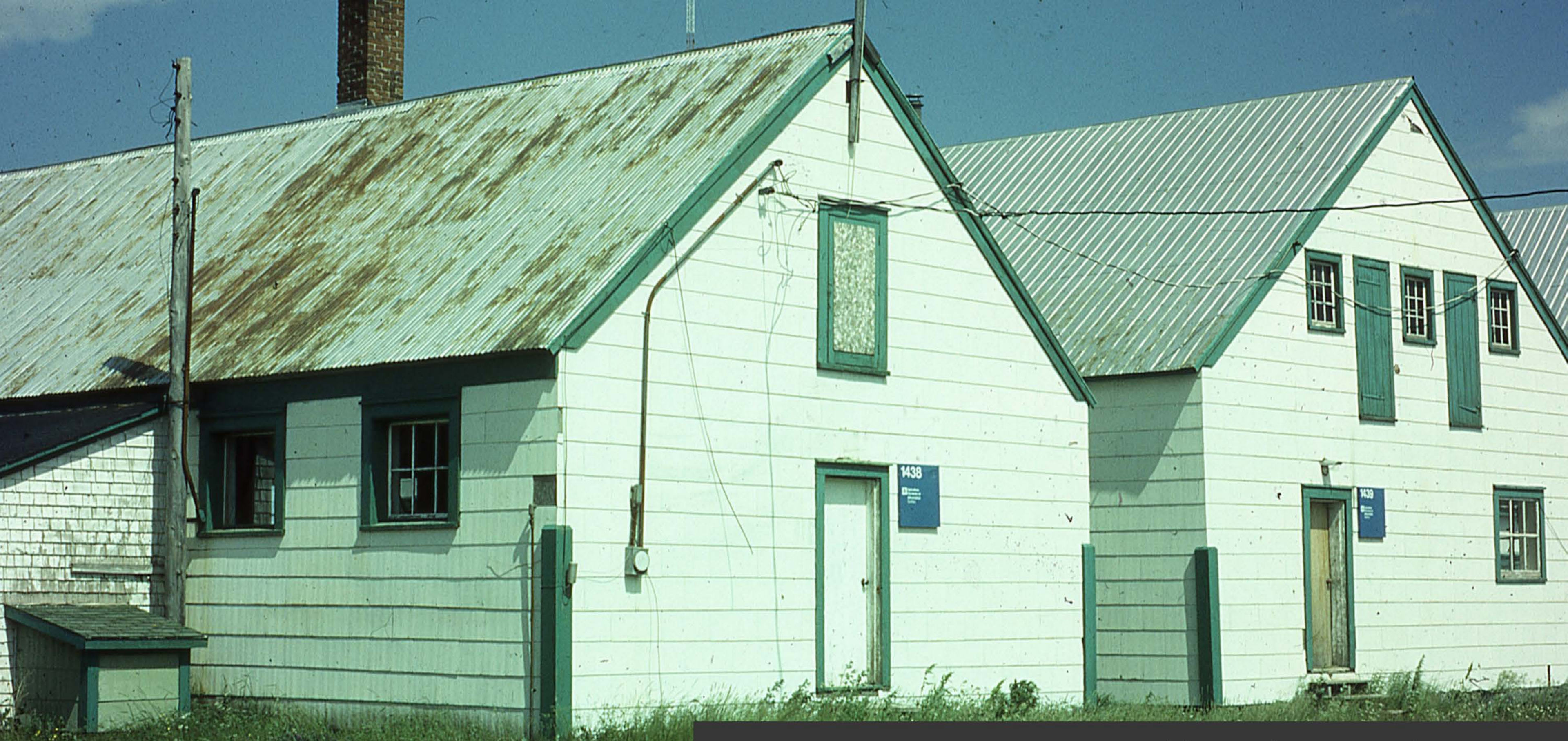
LA PORTE PRINCIPALE A ÉTÉ REMPLACÉE DANS LES ANNÉES 1970. À GAUCHE, UNE ANNEXE A ÉGALEMENT ÉTÉ AJOUTÉE. COLLECTION SITE HISTORIQUE NATIONAL DE PASPÉBIAC.
