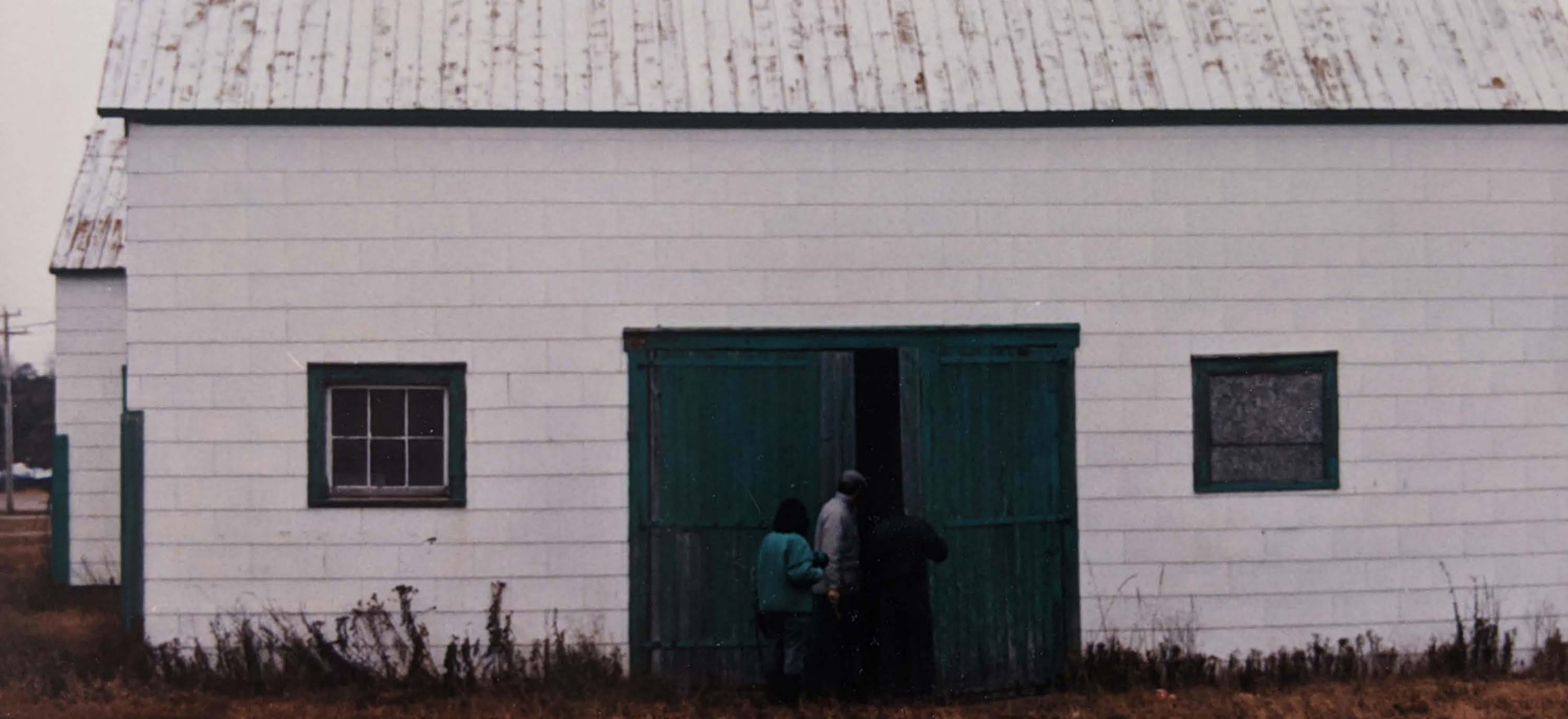
PORTE DE CÔTÉ DE LA FORGE, AVANT SA RESTAURATION, 1988. COLLECTION SITE HISTORIQUE NATIONAL DE PASPÉBIAC.
