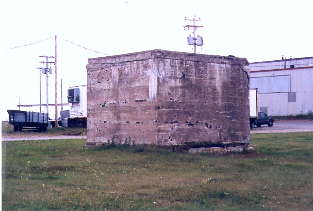
24 Vue de l'arrière de la chambre forte. On aperçoit également une partie de l'usine de transformation de poisson. (N. Clerk, Direction des services historiques, 2000.)
