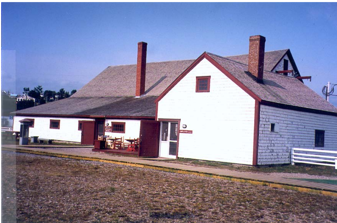
10 Complexe de l'ancienne forge. On y trouve maintenant un restaurant et une salle de spectacles. (N. Clerk, Direction des services historiques, 2000.)
