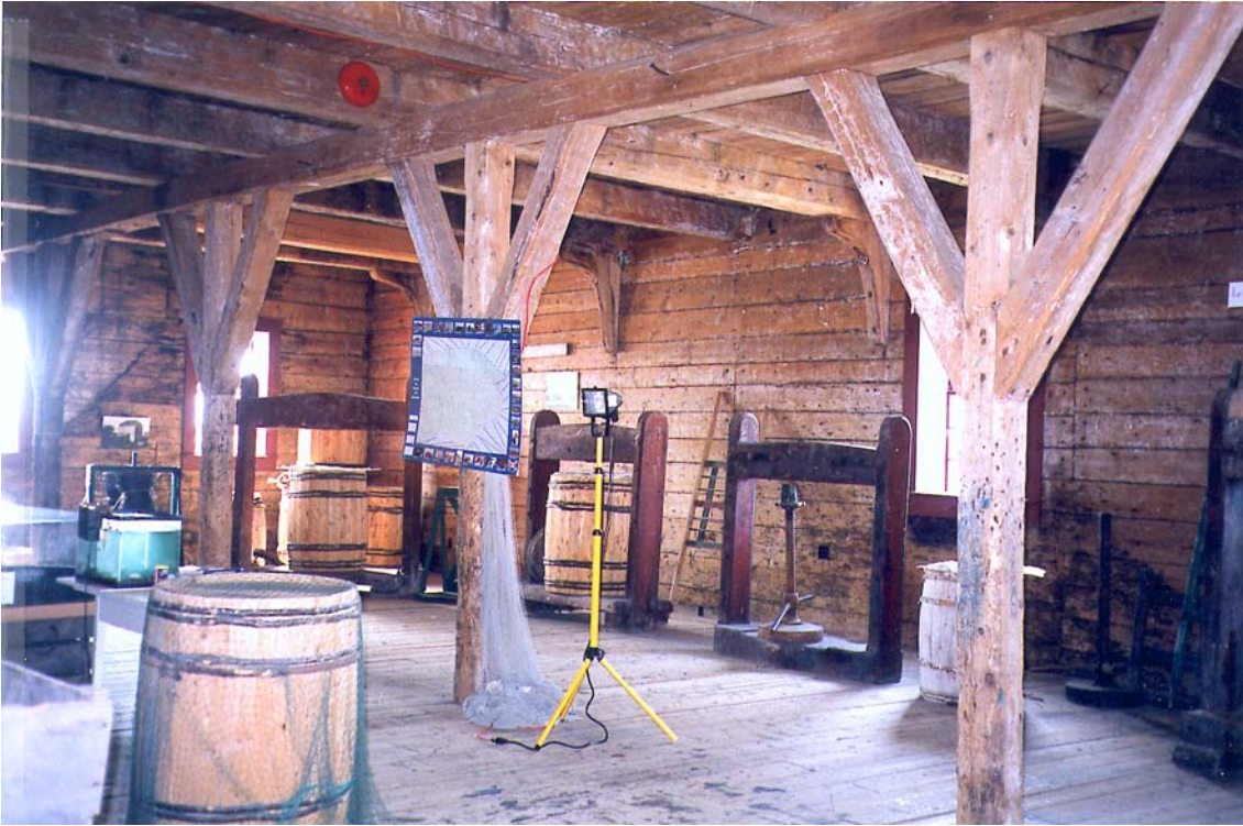
17 Vue intérieure du B.B., au niveau du rez-de-chaussée. (N. Clerk, Direction des services historiques, 2000.)
