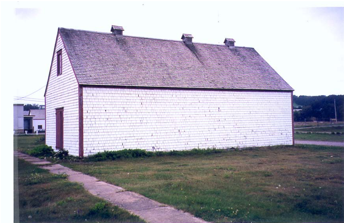
26 Le hangar à farine. (N. Clerk, Direction des services historiques, 2000.)
