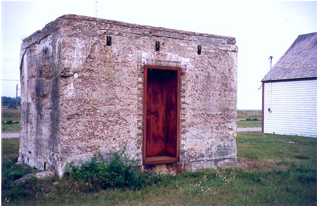
23 Chambre forte, vestige du magasin général qui a brûlé en 1964, située dans le secteur est du site. (N. Clerk, Direction des services historiques, 2000.)
