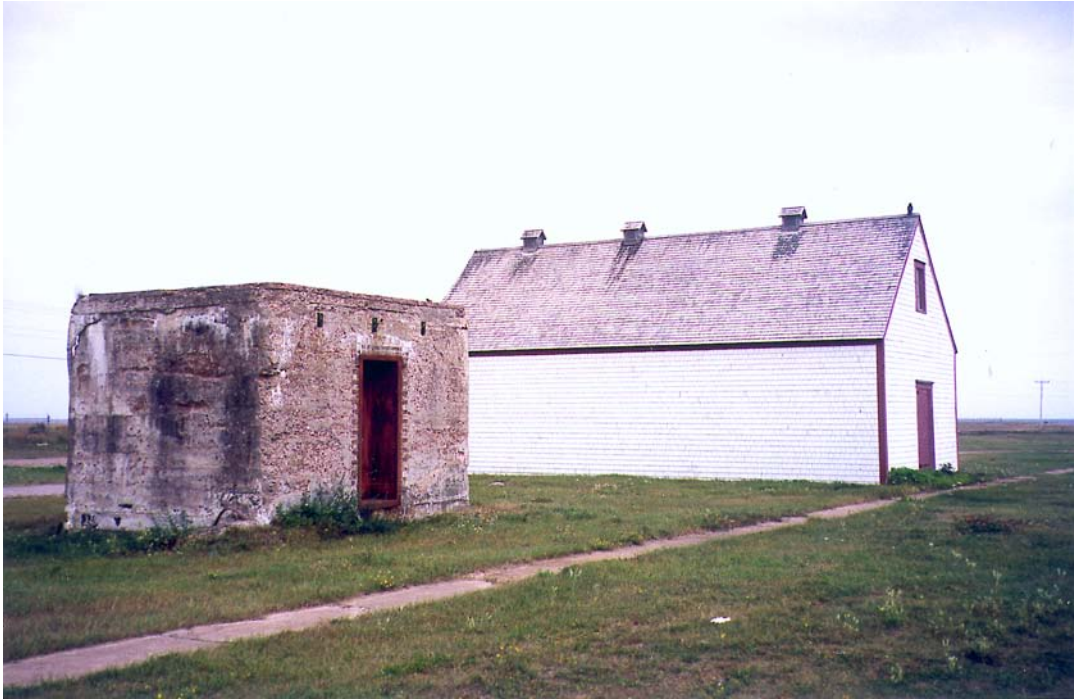
25 Hangar à farine situé dans le secteur est du site. On aperçoit à ses côtés la chambre forte. (N. Clerk, Direction des services historiques, 2000.)
