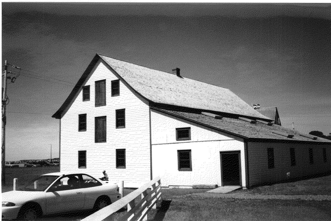
28 Façade arrière de la charpenterie. (Jocelyne Cossette, DSH, juillet 1997.)
