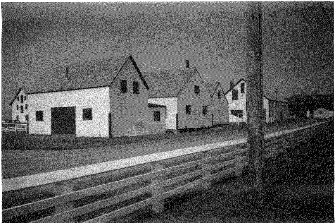
26 Vue arrière des cook-rooms . (Collection du Site historique du Banc-de-Paspébiac, printemps 1997.)
