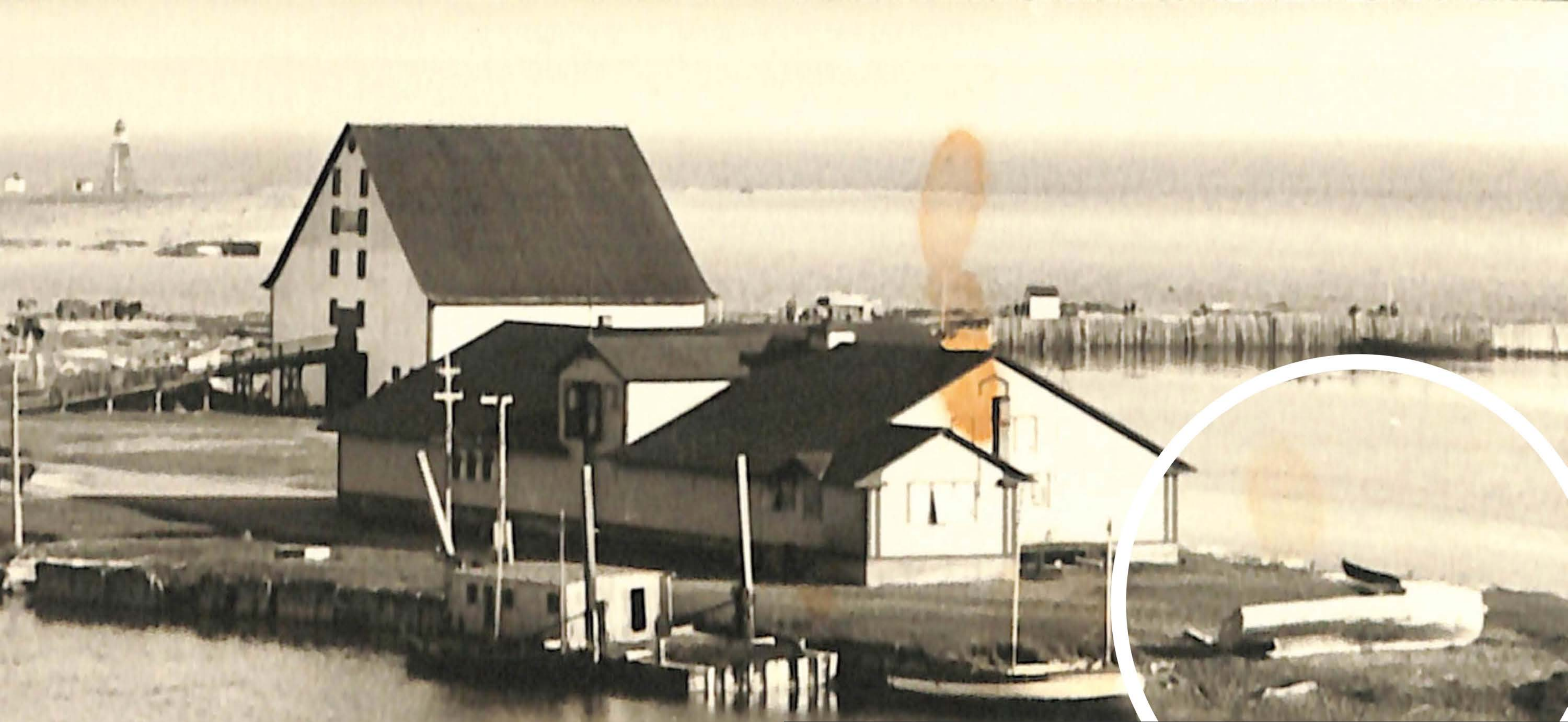
ENTREPÔT FRIGORIFIQUE, VERS 1940 LA PROTECTION CÔTIÈRE NE SEMBLE PAS PRÉSENTE À L'ORIGINE COLLECTION LEILA BOUILLON
