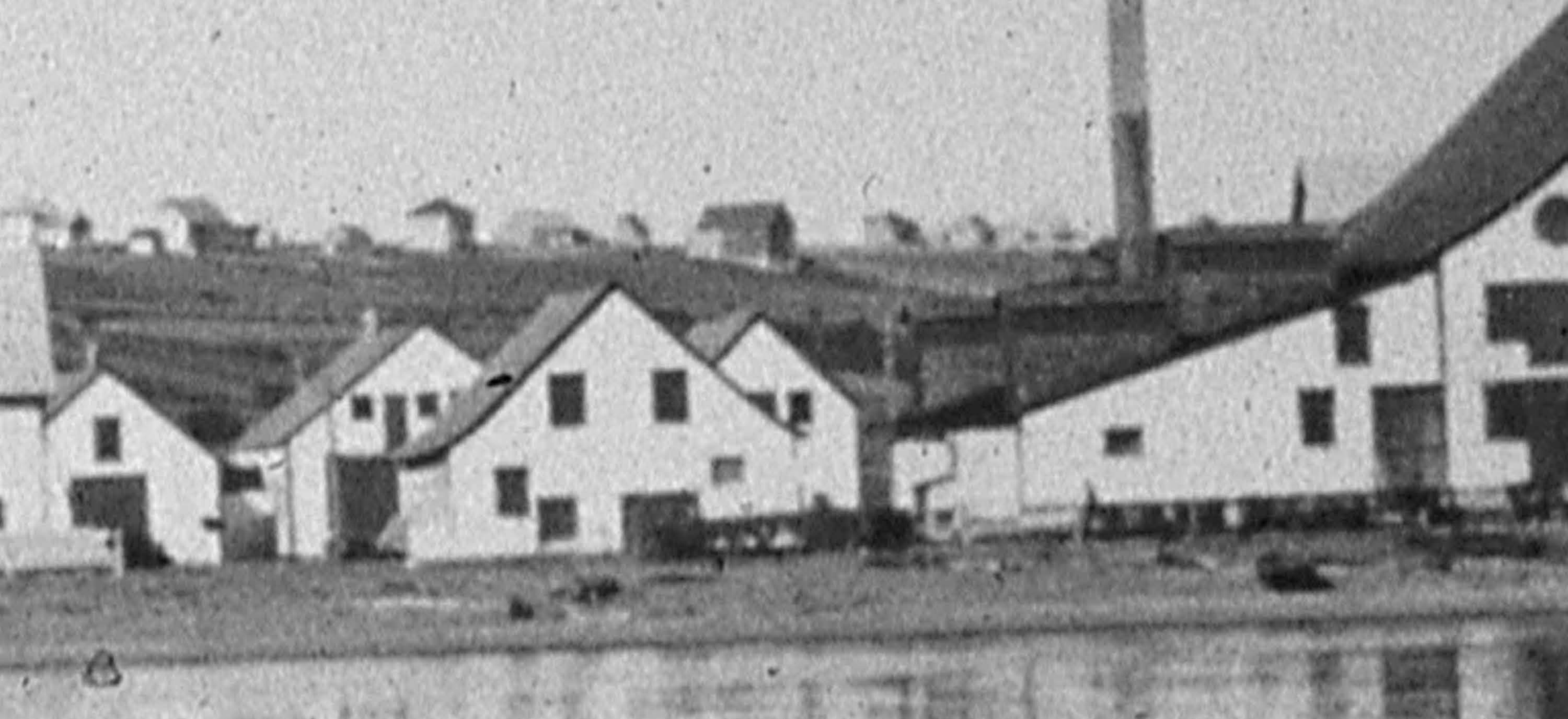
APERÇU DES OUVERTURES DE LA FAÇADE, VERS 1940 COLLECTION SITE HISTORIQUE NATIONAL DE PASPÉBIAC
