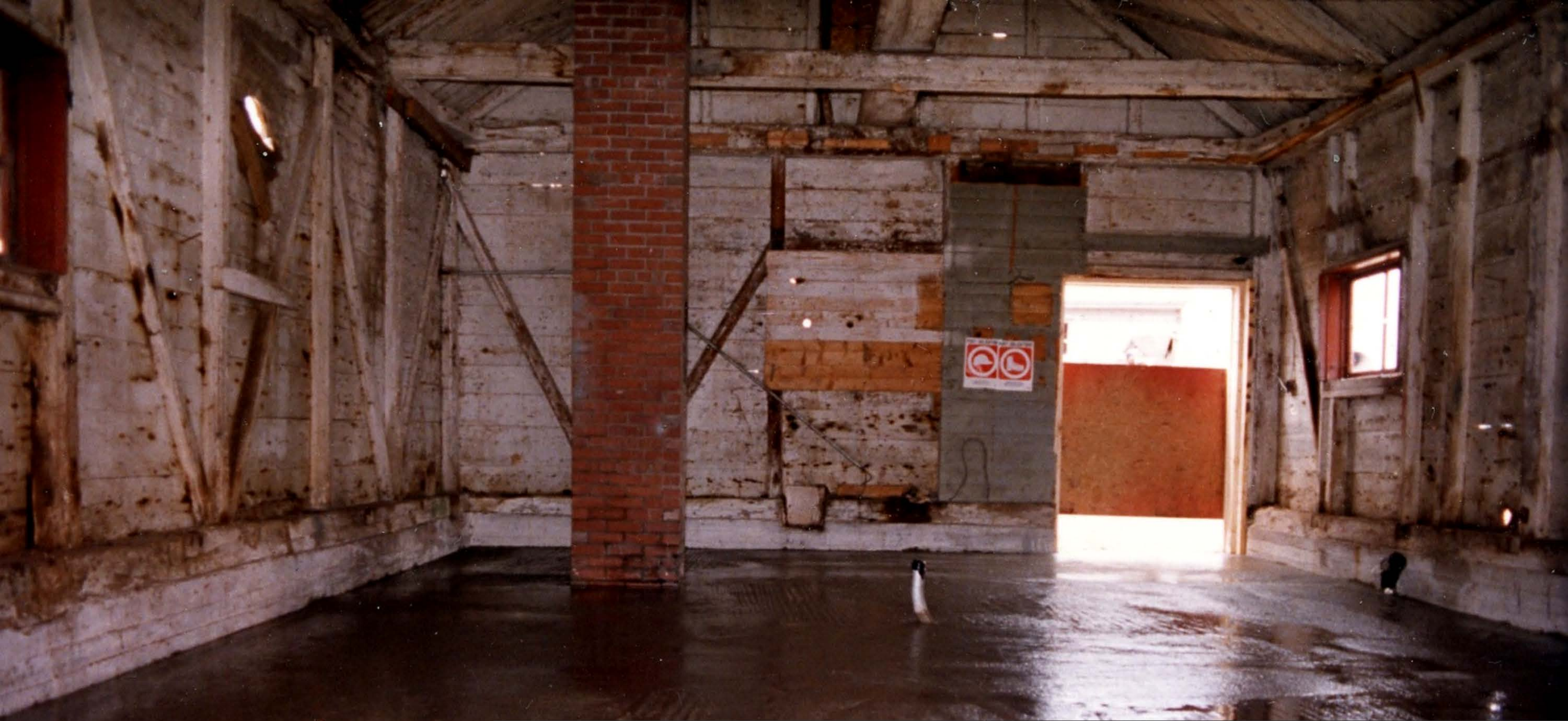
DALLE DE BÉTON, 1988 APERÇU DU CHAULAGE ORIGINAL À L'INTÉRIEUR COLLECTION SITE HISTORIQUE NATIONAL DE PASPÉBIAC
